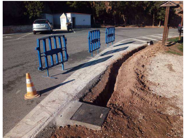
Trabajos sobre la explanada del parking. La arqueta que se observa conecta la nueva tubería con la Fuente de los Tres Amigos , dotándola así de agua potable.
