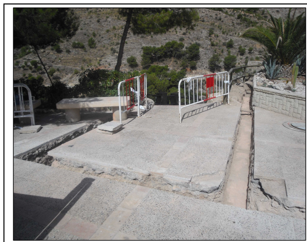
Vista final de las zanjas para la instalación de las tuberías de canalización de agua.
