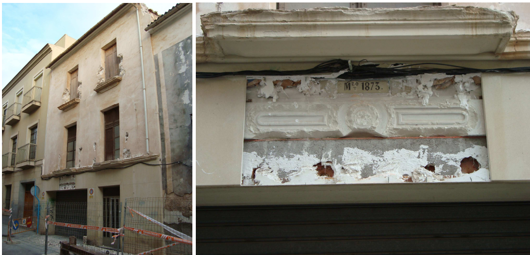
Fachada del antiguo inmueble sito en la calle Sirera y Dara, 34 de Novelda y detalle del dintel de la puerta recuperado, fechado en marzo de 1873.
