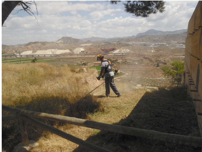
Trabajos de limpieza y mantenimiento en el Castillo de La Mola durante el mes de Junio de 2013.
