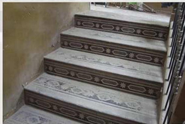
Losetas hidráulicas utilizadas en escaleras. Fabricada por NAVARRO & C a - NOVELDA (1894-1896) C/ Sirera y Dara, 31 - Novelda
