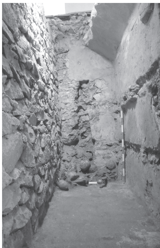
Figura 8. Interior de la cripta durante la excavación.
