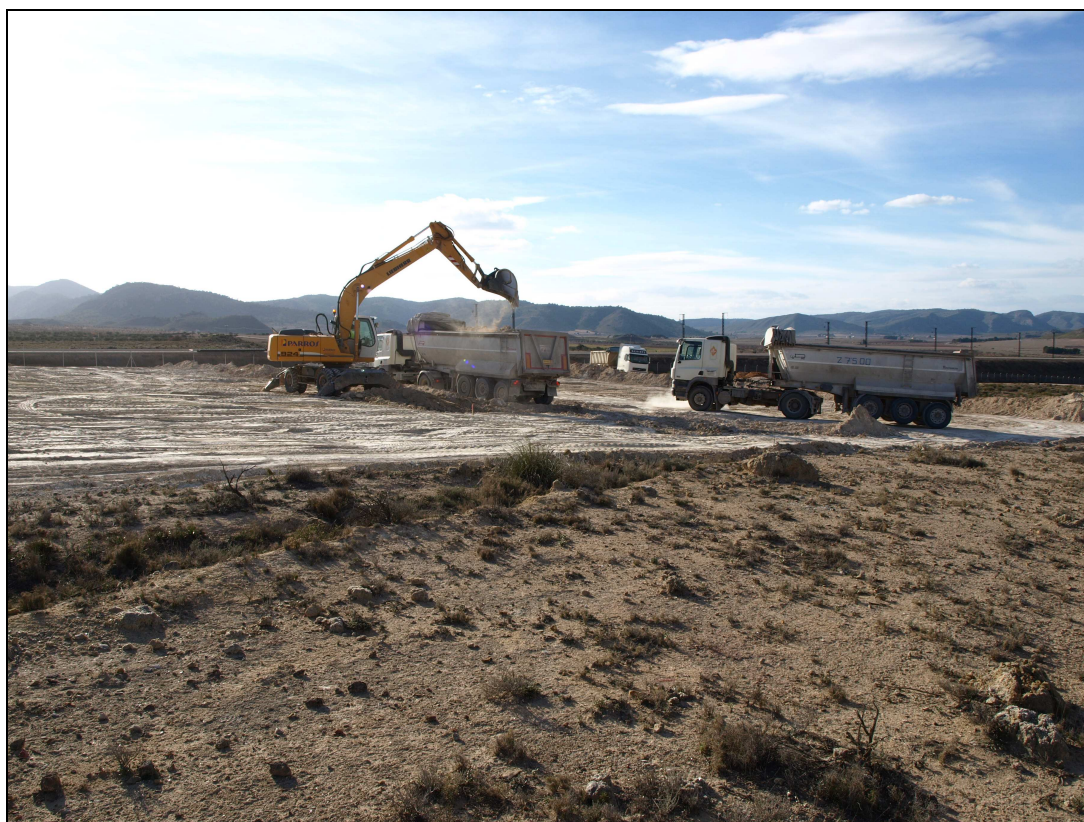
Vista del desarrollo de los trabajos.
