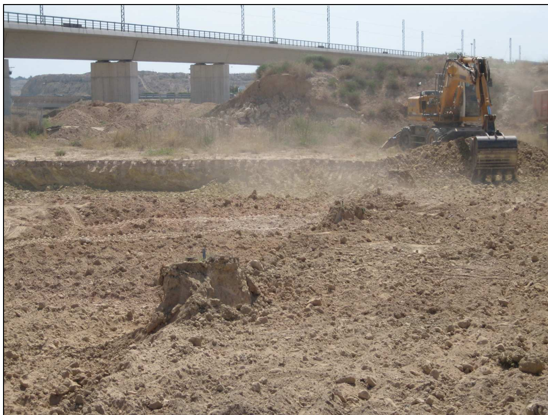
Vista del desarrollo de los trabajos.
