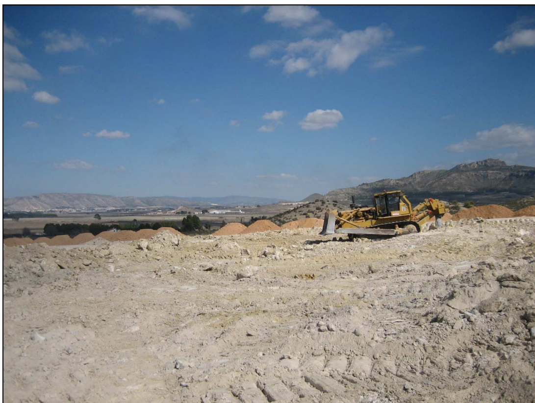
Vista del desarrollo de los trabajos.
