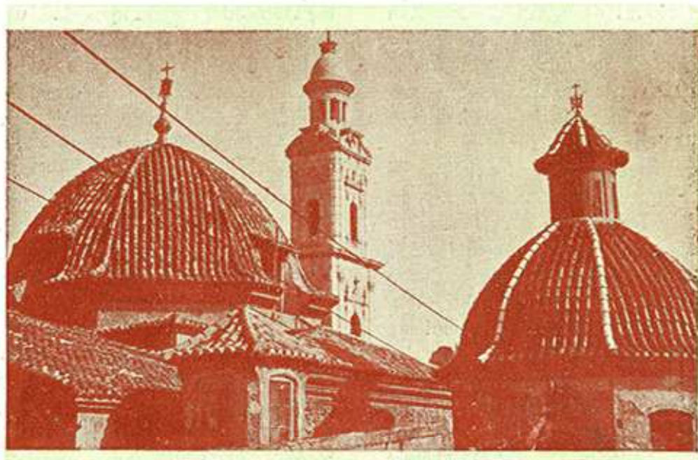
Cúpulas y torre de la Iglesia Arciprestal
