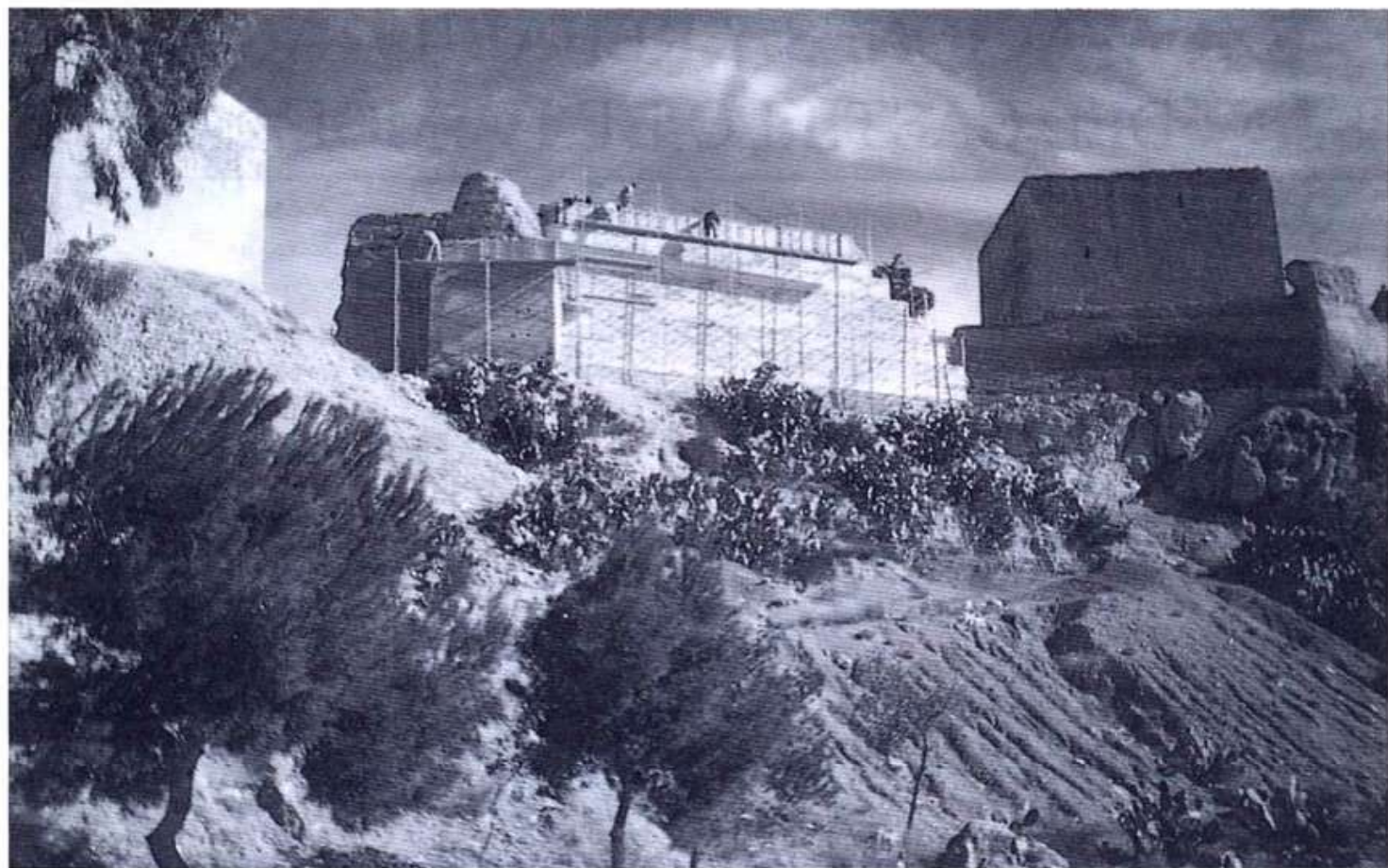
Castillo de La Mola: Trabajos de reconstrucción, en tapial, del lienzo Suroeste.
