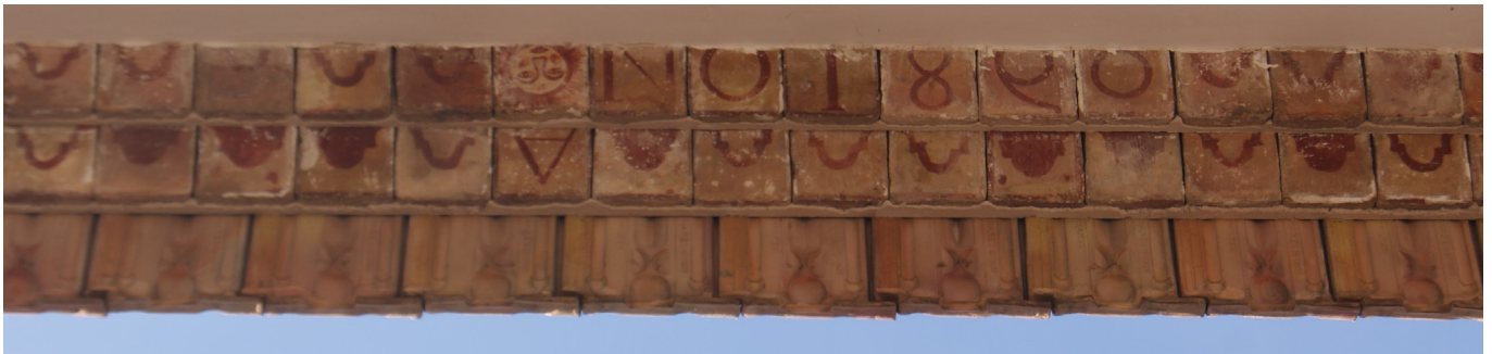
Fig. 3. Alero con ladrillos pintados en C/ San Rafael nº 15. Fotografía de la autora
