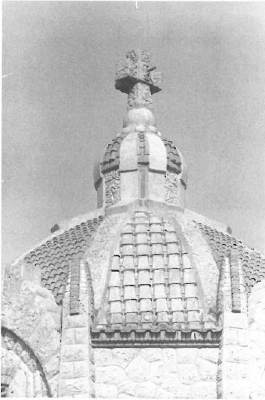
4. Detalle de la cúpula sobre ochavada construida dentro de la tradición local.
