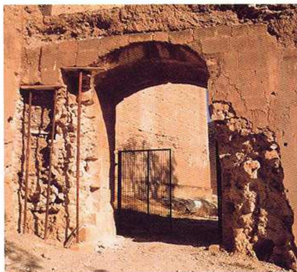
Vista del estado de la puerta previo a su restauración.
