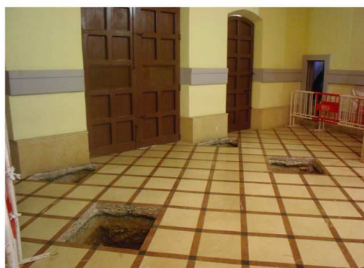
Vista general de los Sondeos 1, 2, 3 y 4.
