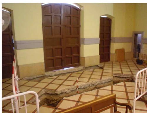
Vista final de los sondeos y las trincheras excavadas.
