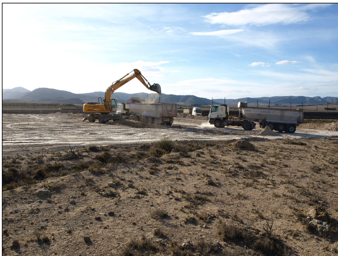
Vista del desarrollo de los trabajos.
