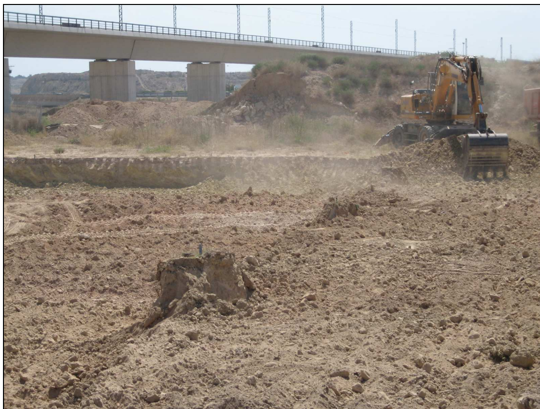
Vista del desarrollo de los trabajos.
